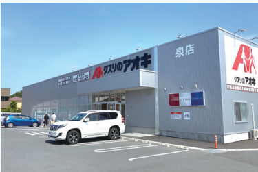
【泉町下川第一テナント】 ドラッグストア
