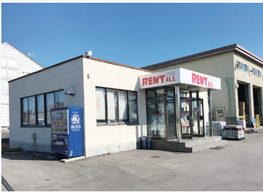
【アドレスいわき常磐ビル】 重機レンタル
